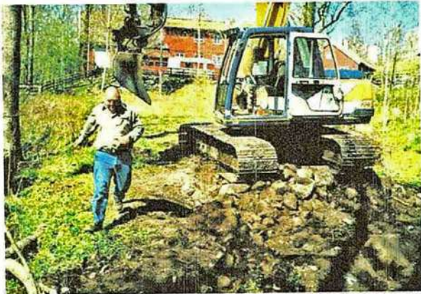
Arne Ekvall er i gang med å grave ut tomte der kraftstasjonsbygget skulle stå.
