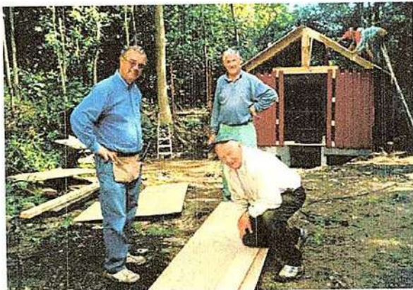
Kraftstasjonsbygget er snart ferdig. Fra venstre: Leif Steen Jensen, Gunnar Gulvik og Ivar Sølyst.
