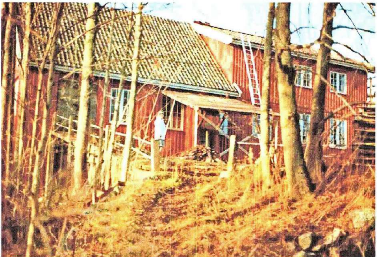
I april – mai 1983 var Mølla ferdig restaurert utvendig, ny kledning som er malt to strøk.
