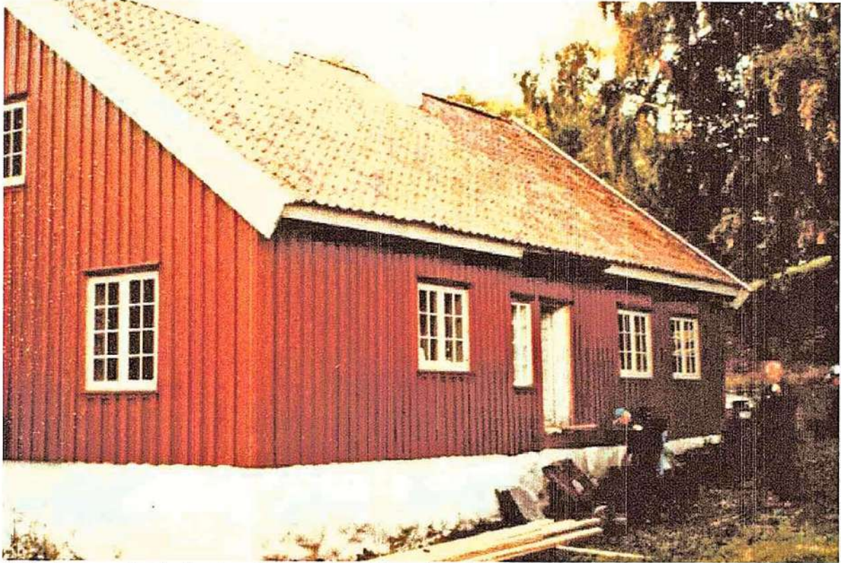
Møllestua er nesten ferdig utvendig, ny kledning ble malt med to strøk. Taket ble lagt om, men nye piper er ikke på plass.
