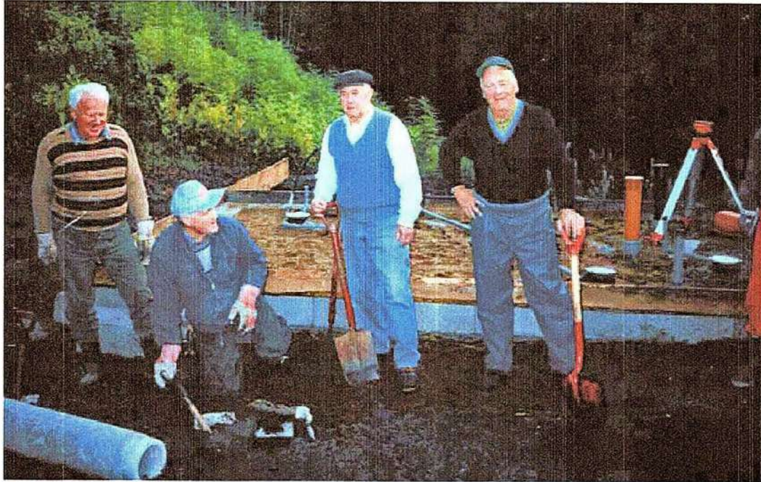
Grunnarbeidet til toalettbygget er ferdig. Fra venstre: Hans Kaasa, Ivar Rykkelid, Sverre Tvetene og Ivar Sølyst.
